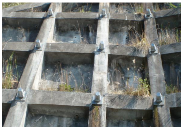
写真-2.4 計測のり面の可視画像
