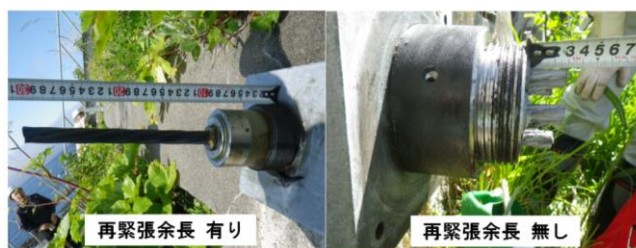
写真-3.1 アンカーの再緊張余長の例
