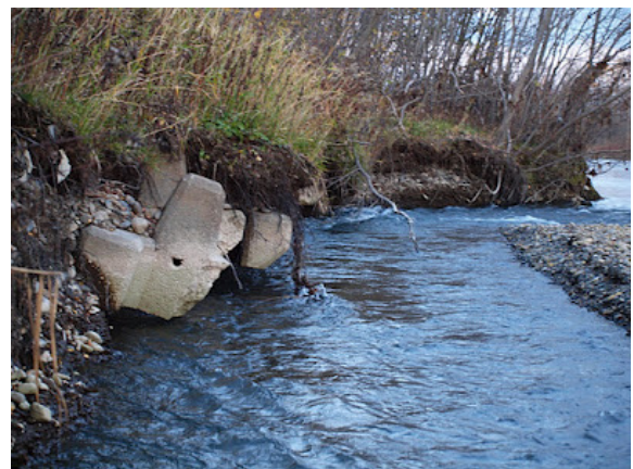
写真-2 石狩川上流における護岸根固工
