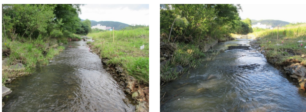
図-27b 出水前後の河床状況（ネット+覆礫区間） 左：出水前，右：出水後，覆礫土砂が維持
