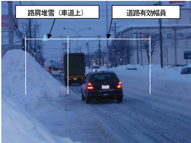
写真1 路肩堆雪と道路有効幅員
