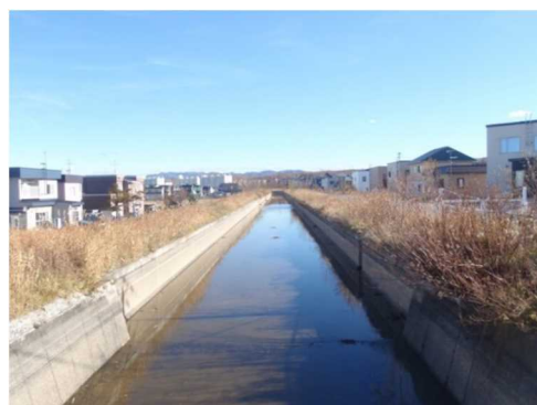
図-2 用水路と住宅地の近接状況
