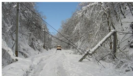
写真-3 暴風雪に伴う電柱の倒壊・電線の切断 (豊浦町ホームページ 3) より引用)
