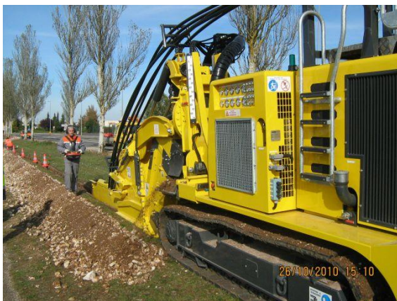
写真-13 ケーブル同時埋設・遠隔操作機能 ホームページより引用 18)
