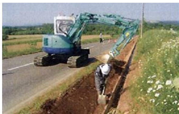
写真-11 国内における油圧ショベルによる施工例 道内自治体提供
