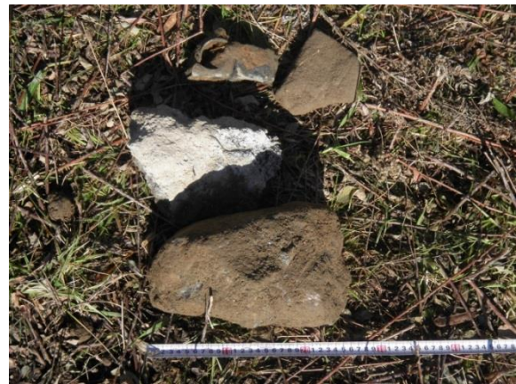
写真-16 詰まりの要因となった玉石
