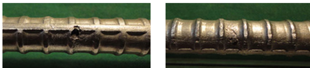
(a)孔食による断面欠損を伴う腐食
