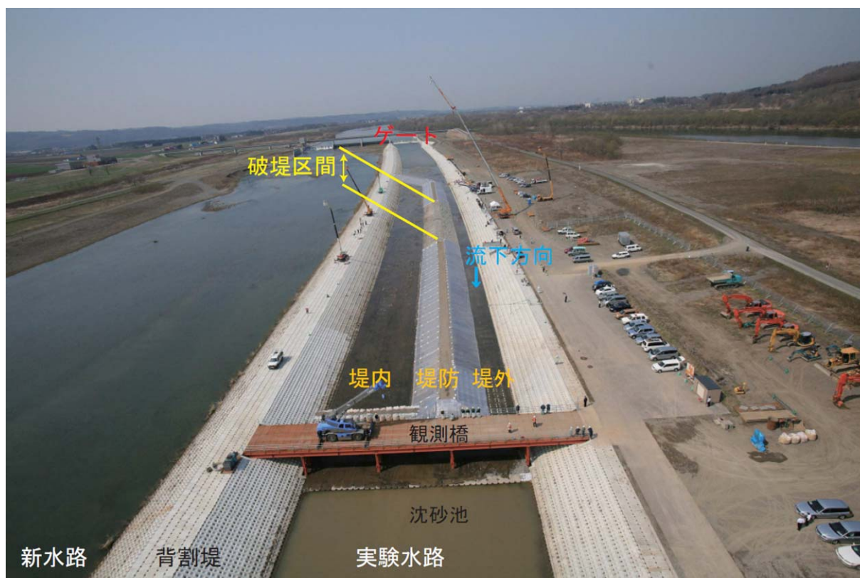
写真 3.1 実物大堤防の破堤実験施設の概要
