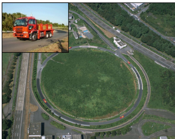
写真-2 舗装の促進載荷試験場
