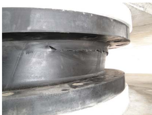
(b) 免震支承に生じたき裂
