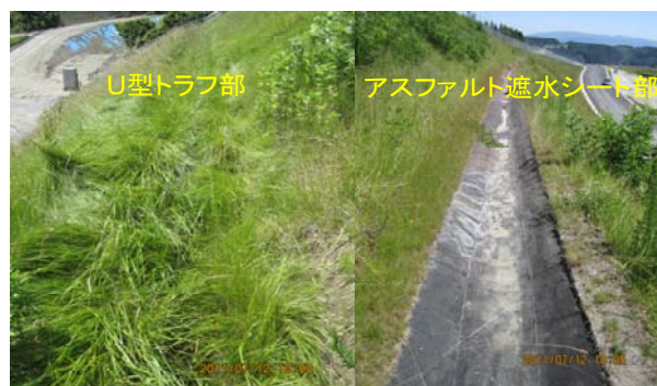
写真-4 小段排水溝の防草効果
