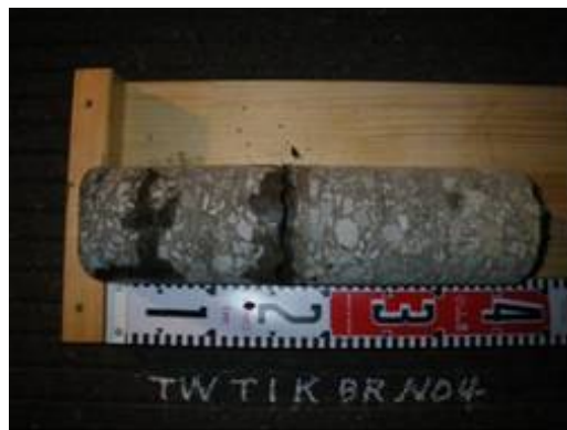
写真-5 ブリスタリング発生箇所の採取コア
