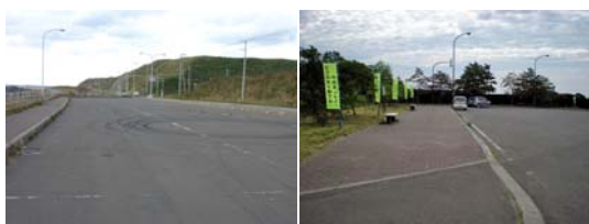
写真-3 快適な駐車空間や休憩施設となっていない事例
