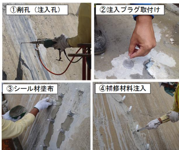
写真-4.1 ひび割れ補修状況例（注入工法）
