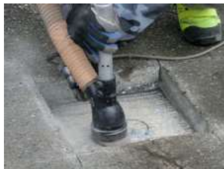
サンドブラストで既設防水工を撤去
