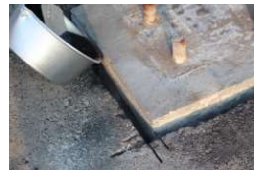
加熱施工式注入目地材
