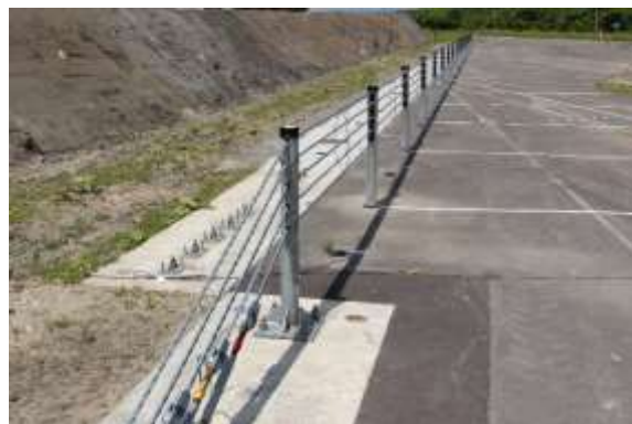
防護柵設置状況 (端末)
