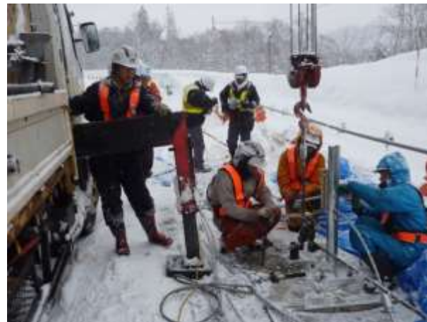
クレーンでワイヤロープを緊張
