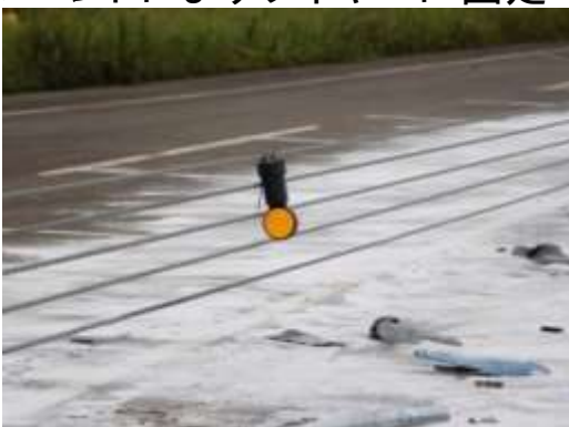
車両衝突時においても飛散しない
