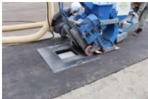
鉄製型枠を使用したブラスト工法
