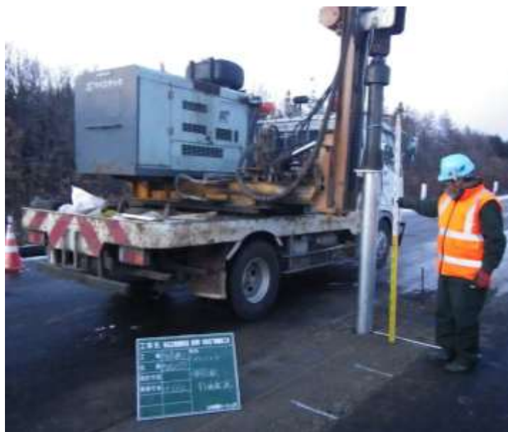
打ち込みアタッチメント使用状況
