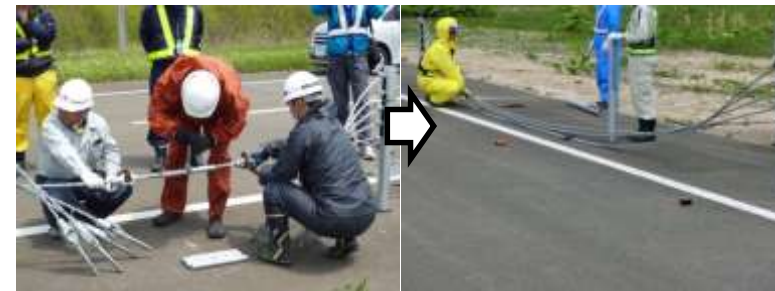
支柱は人力で脱着し、開口部を設置
