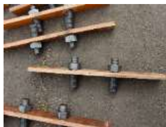
アンカーボルトの型枠
