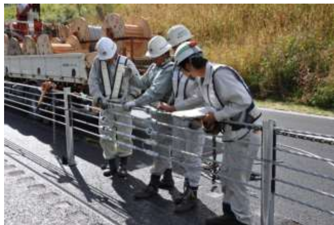
中間ターンバックルの取り付け
