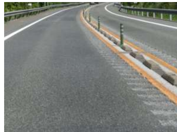
京都縦貫道(園部IC~丹波IC)に設置された大型車対応ランブルストリップス
