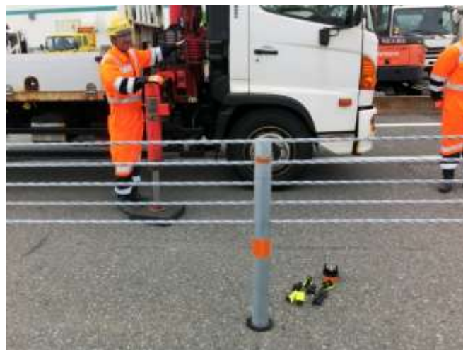
ワイヤロープを降ろし、回転式間隔材を使用
