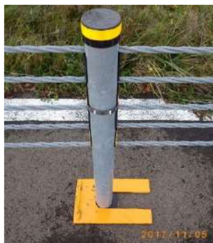
スリーブ浮き上がり防止治具
