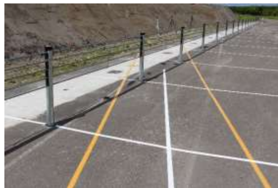
防護柵設置状況 (中間支柱)
