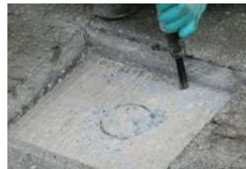
ジェットタガネで四隅の既設防水工を撤去
