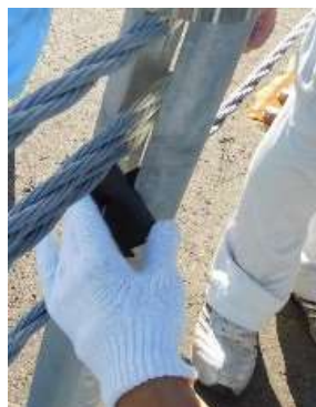
回転式間隔材の取付方法
