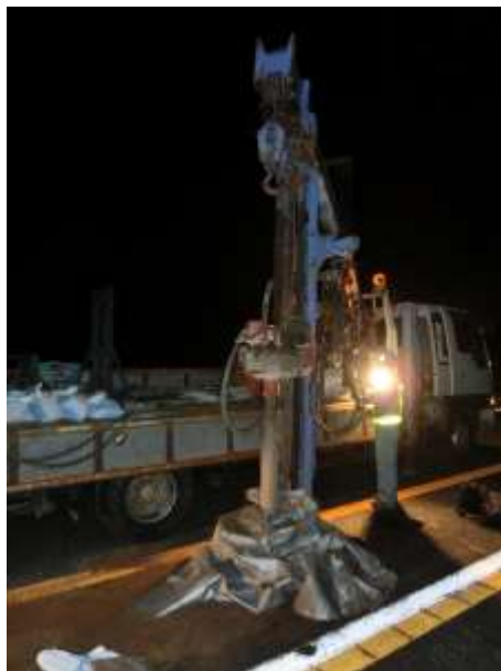
岩削機による削孔状況
