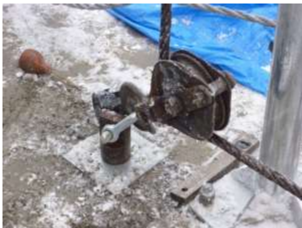
端末基礎にアンカー取り付け
