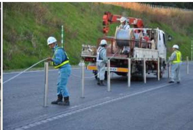
ワイヤロープの設置
