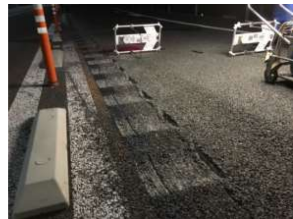
大型車対応ランブルストリップス施工状況 (ランブル施工後に、導流レーンマーク、ワイヤロープを施工)
