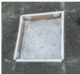
防水材の溝の型枠
