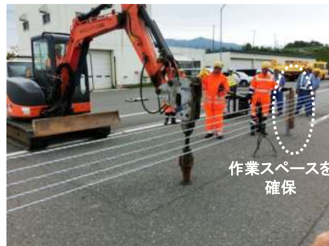
スリーブ管打ち込み用治具使用状況
