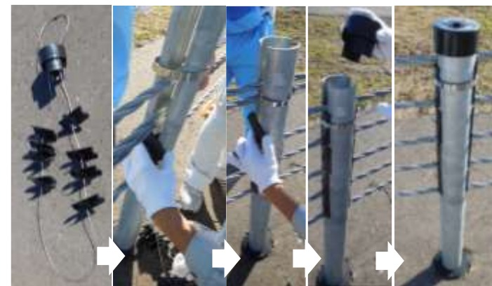
孔あき樹脂キャップ、回転式間隔材、飛散防止ワイヤ
