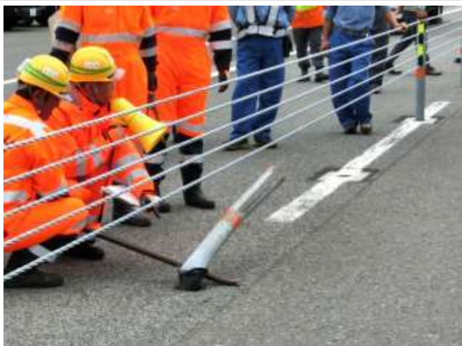
支柱が抜けない時は支柱を少し起こす
