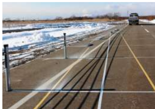
車両衝突後の状況
