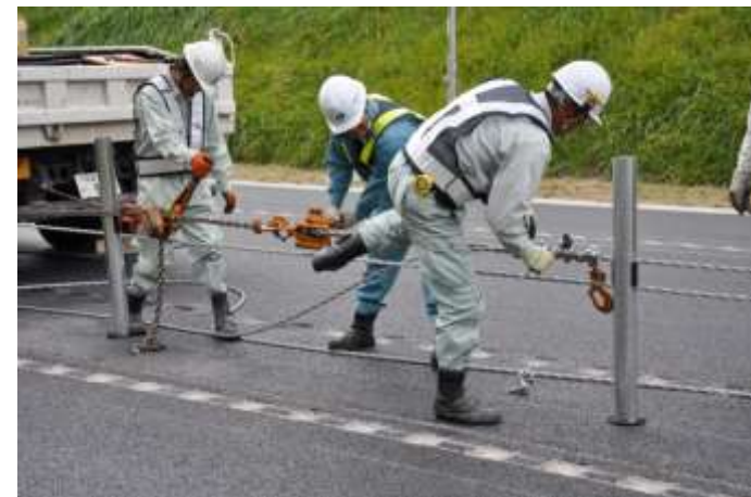
レバーブロックで仮緊張
