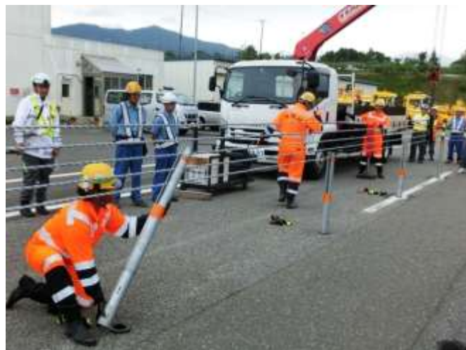
ワイヤロープを緩めることなく支柱を交換
