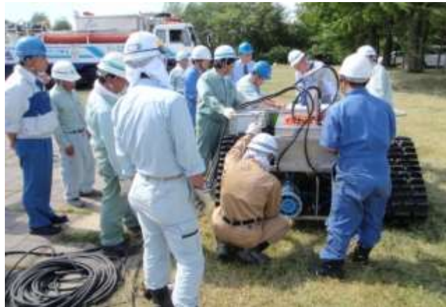
排水ポンプ搭載作業
