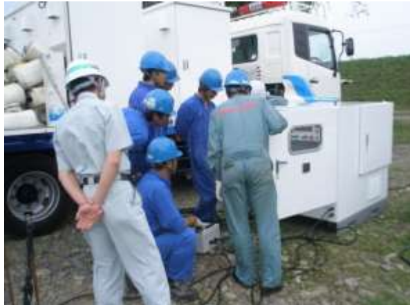
操作盤接続作業
