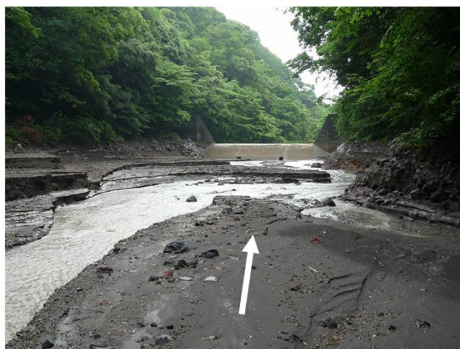
H23.6.13 掘削後に堆積した形跡なし
