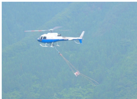
水位計の運搬状況
