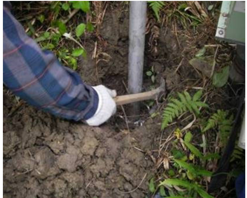
台座・ピン打込み
