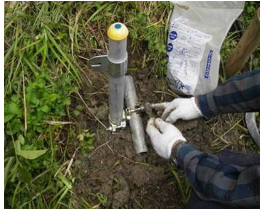
安定用単管設置
