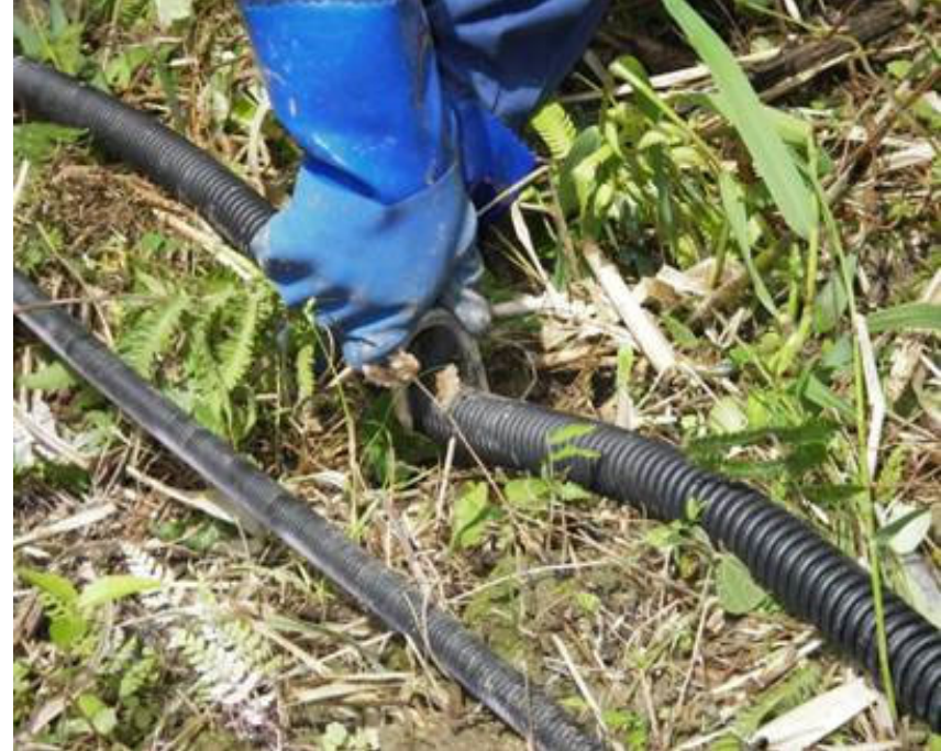
保護管の固定
