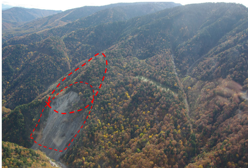
斜面崩落と背後に想定される地すべり (撮影:平成23年10月)
