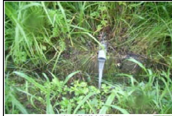
ドレーン部の排水状況1
