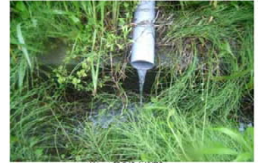
ドレーン部の排水状況2
