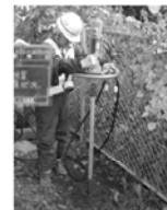
サウンディング孔を利用してパイプロハンマーで観測井を設置
