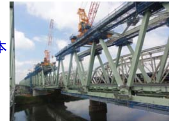
常磐線根川橋りょう架替
