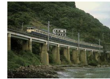
内房線山生橋りょう 経年88年(大正13年竣工)
