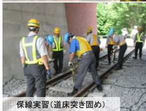
保線実習(道床突き固め)
