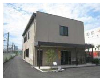
実習棟 (東京支社)
