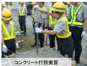
コンクリート打設実習
