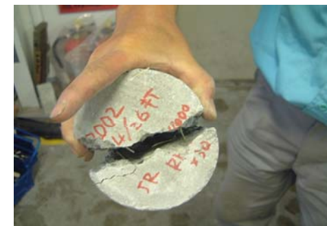
剥離しても落下しない様子
