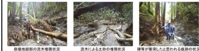
崩壊地脚部の流木堆積状況
