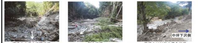
溪流内の流木堆積状況
