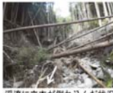
溪流に立木が倒れ込んだ状況
