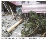
半壊家屋上流側に堆積した土砂
