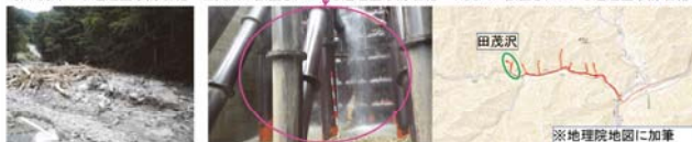
不透過型砂防堰堤上流部での捕獲状況
