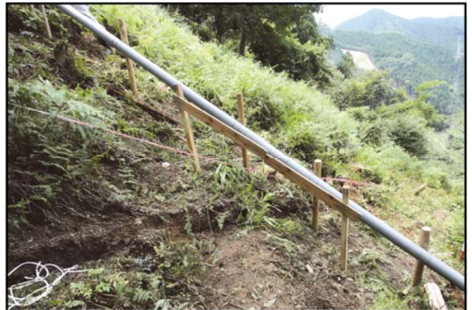
斜面に向かって右側、斜面中腹で認められた約70mにわたって連続する亀裂 16 開口幅10~15cm, 段差10cm程度
