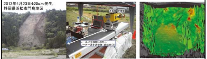
崩壊の拡大が懸念された斜面
