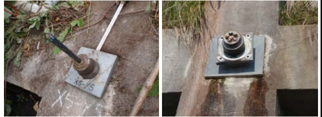
緊張力を解除しても十分な余長があり、テンドンが引き込まれる心配がない。
