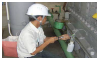
排水機場等機械設備の潤滑油分析による劣化診断
