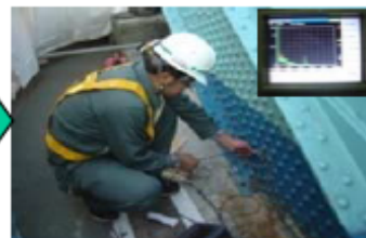
超音波による非破壊検査 コンクリートへの埋込部の点検・診断
