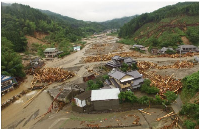
2017年九州北部豪雨_流木が堆積している様子
