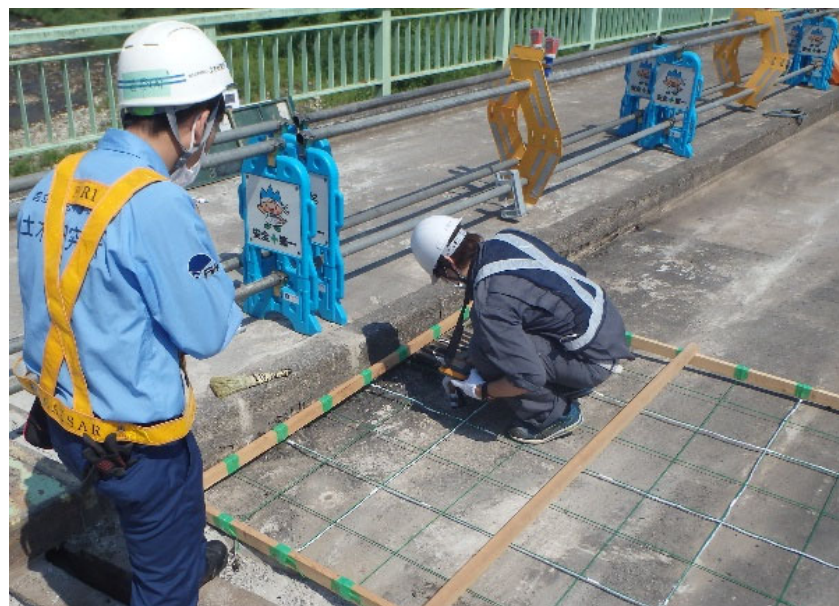
床版上面水分量計測
