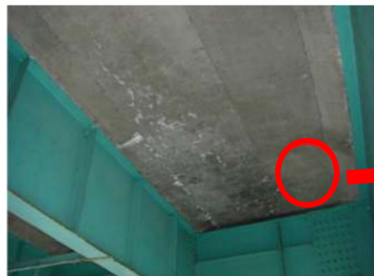
損傷の兆候無し(5年前)
