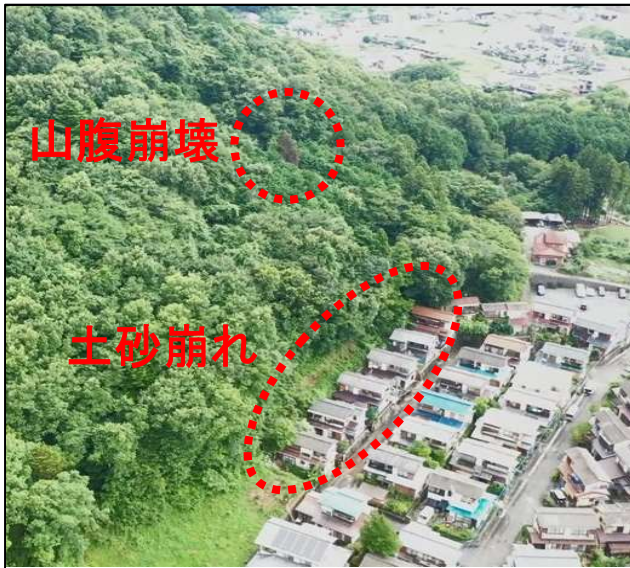
ドローンによる被災状況調査
