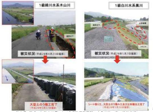
熊本県 平成28年熊本地震における堤防損傷箇所の応急対策工事の進捗状況について
