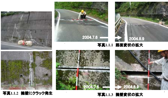
写真1.1.2 擁壁にクラック発生
