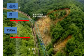
写真2.4.3 災害直後の状況
