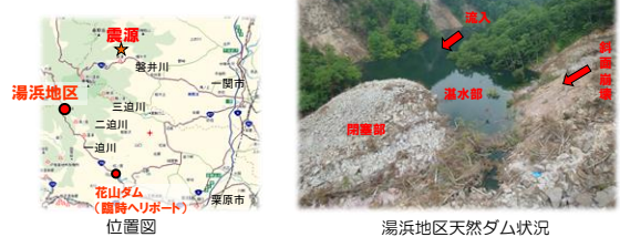
湯浜地区天然ダム状況
