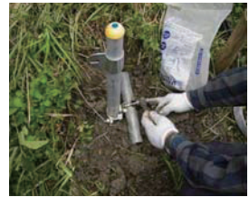
安定用単管設置
