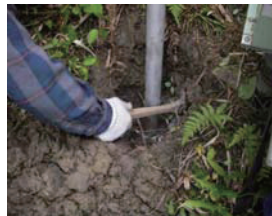
台座・ピン打込み
