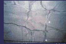
コールドジョイントとひび割れとの組合せでブロック化
