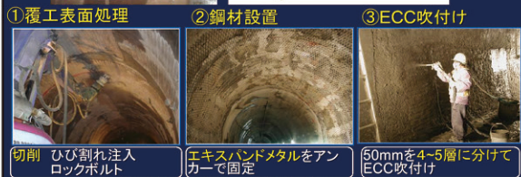
鋼材と高韌性セメント複合材料(ECC)を用いた薄肉吹付けトンネル補強工法
