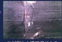
ひび割れと横断目地との組合せて半月状にブロック化
