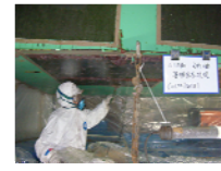
2回目塗膜除去作業
