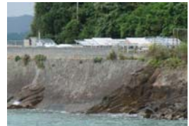
沖縄県 大宜味村「沖縄建設材料耐久性試験施設」
