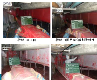
桁部 1回目のはく離剤作業後
