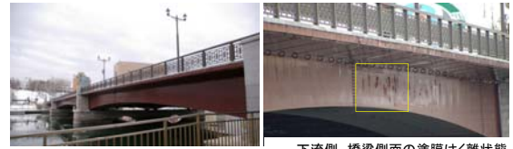
上流側の橋梁側面全景
