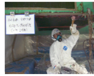
2回目塗付け作業0.5kg/m 2
