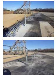
防護柵設置状況
