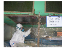
2回目塗膜除去作業
