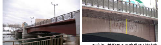
上流側の橋梁側面全景
