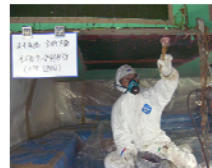
2回目塗付け作業0.5kg/m 2
