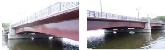
上流側 橋梁外側全径
