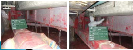
桁部 1回目はく離剤作業後
