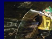
4. NAVシート貼り付け
