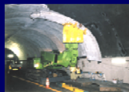
①施工写真
