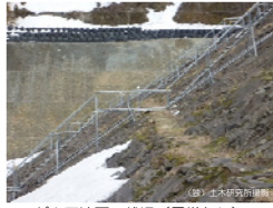
ダム下流面の状況(異常なし)
