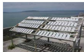
暴露試験状況: 独立行政法人土木研究所 沖縄暴露試験場 (沖縄県大宜味村)
