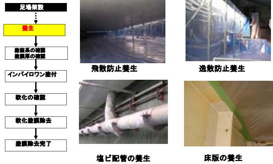
塩じ配管の養生
