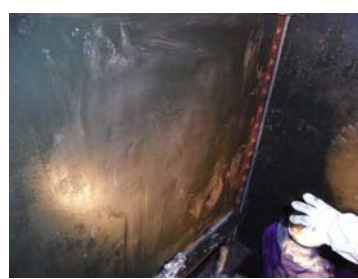
塗膜除去完了
