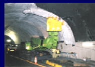
①施工写真
