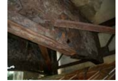
桁端部の腐食破断
