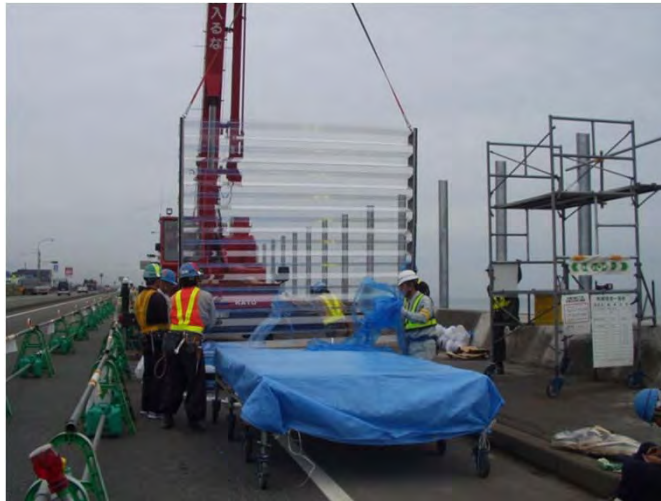
工場製作した部材を搬入
