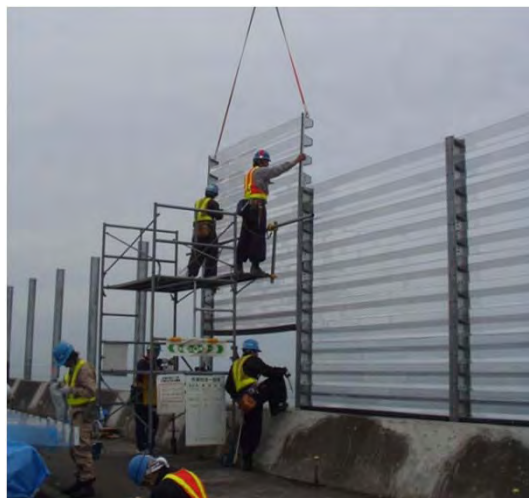
H鋼と部材をボルトで接合
