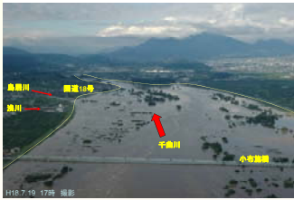
立ヶ花秩那部 (H18.7豪雨の出水状況)
