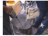
ハンドミキサーによる充填材攪拌状況
