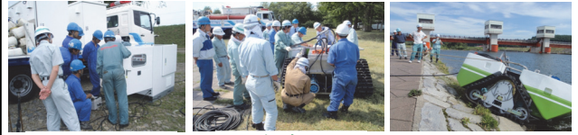
操作盤接続作業
