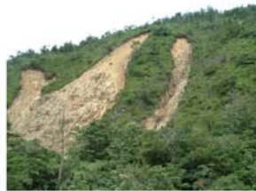
①斜面崩壊
