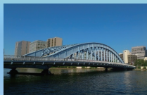
永代橋の耐震補強調査事例
