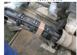
逆流防止材設置状況
