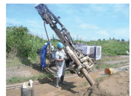
アンカー材挿入状況
