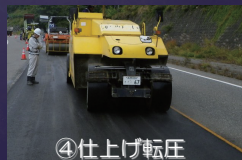
④仕上げ転圧
